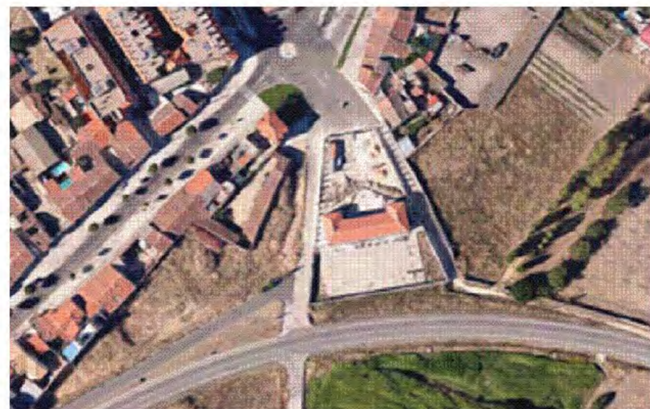
PISTA POLIDEPORTIVA DE SAN FRONTIS (ESCUELAS)
